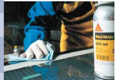
Fig. 128 Applying Sika® Aktivator
